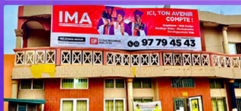
◉ IMA PARAKOU : Banikanni, immeuble CLCAM, sur la voie pavée menant à la pharmacie du Campus.
